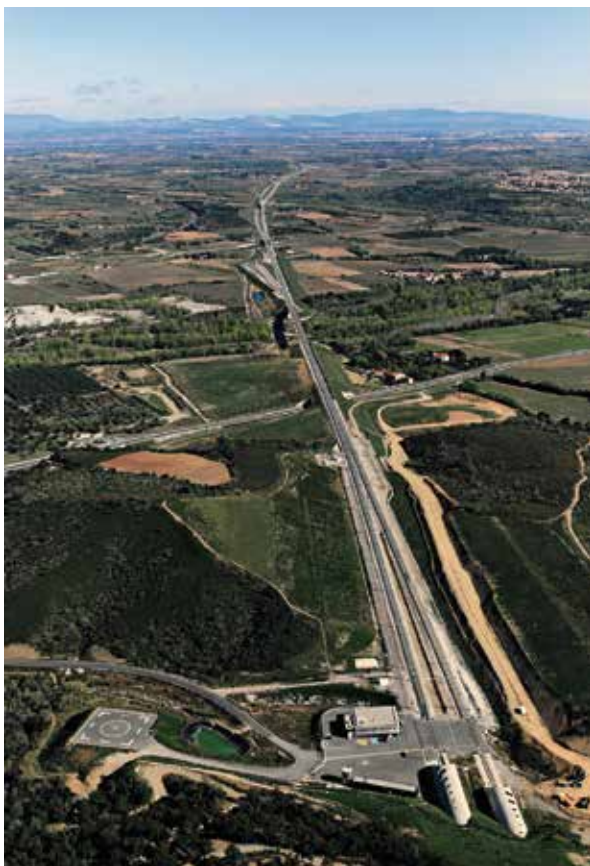
Figura 12. El túnel del Pertús, pas fronterer en alta velocitat i ample internacional entre Espanya i França (boca nord). Font: Oficina del Corredor Mediterrani del Govern d'Espanya.
