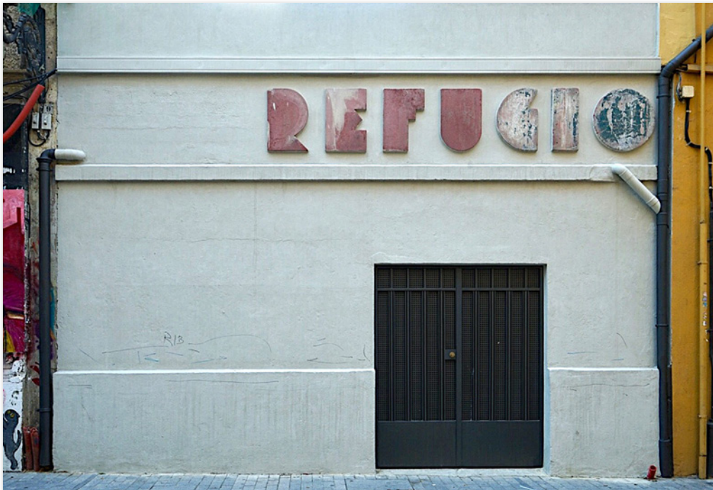
Façana del refugi antiaeri del carrer dels Serrans-Palomino amb el característic rètol amb lletres art déco durant el procés de restauració. Fotografia de José M.ª Azkàrraga (València, maig 2017).
